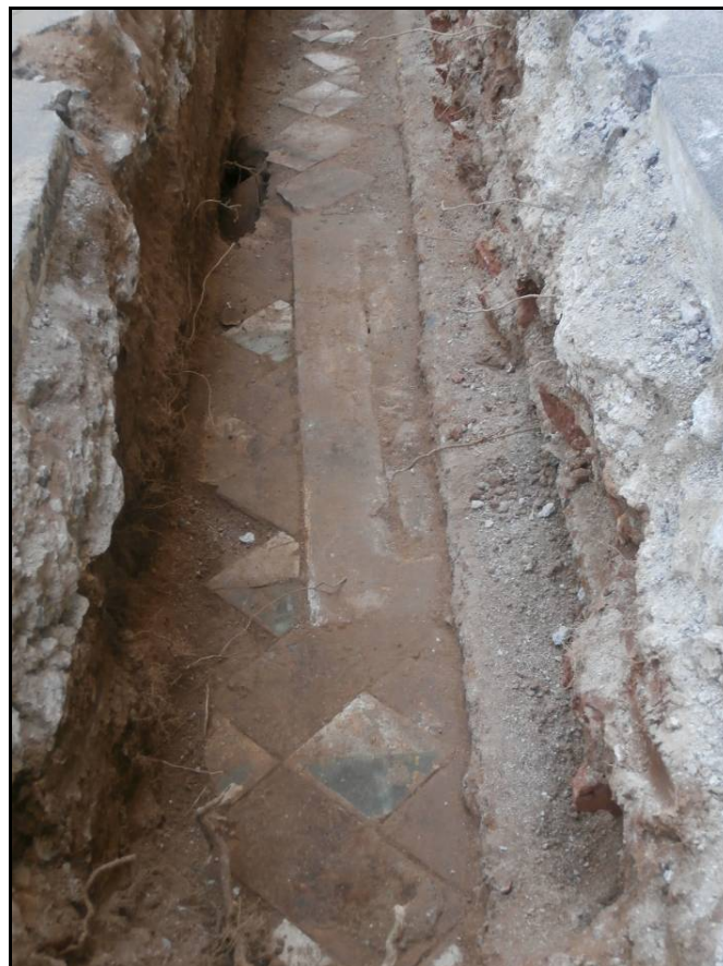
Fotografia 8: Paviment de rajoles (UE 105) i dipòsit al nº 4 del carrer dels Àngels.
