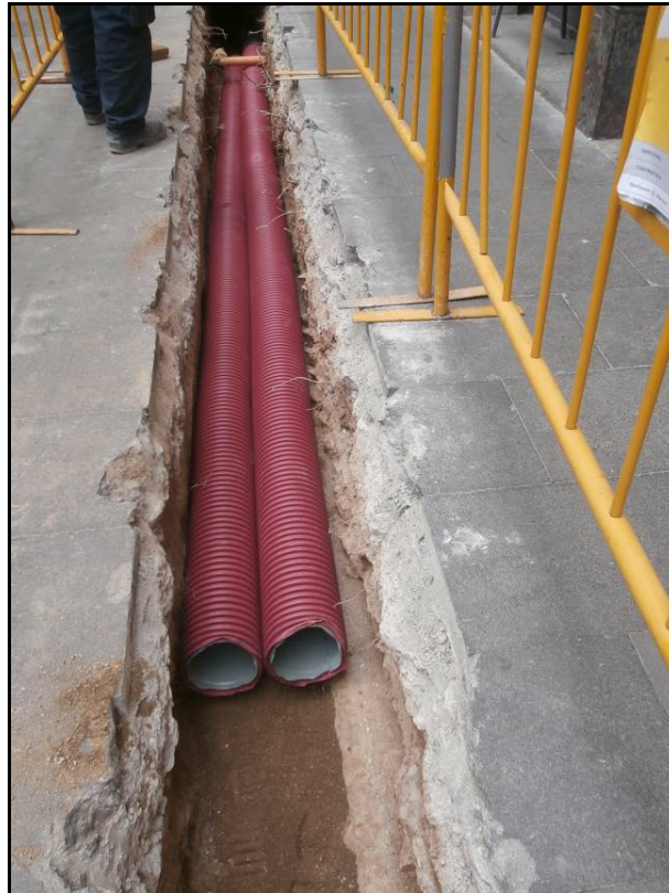
Fotografia 13: Col·locació dels tubs per sobre de la cota del paviment i dipòsit documentats a la Rasa 1.
